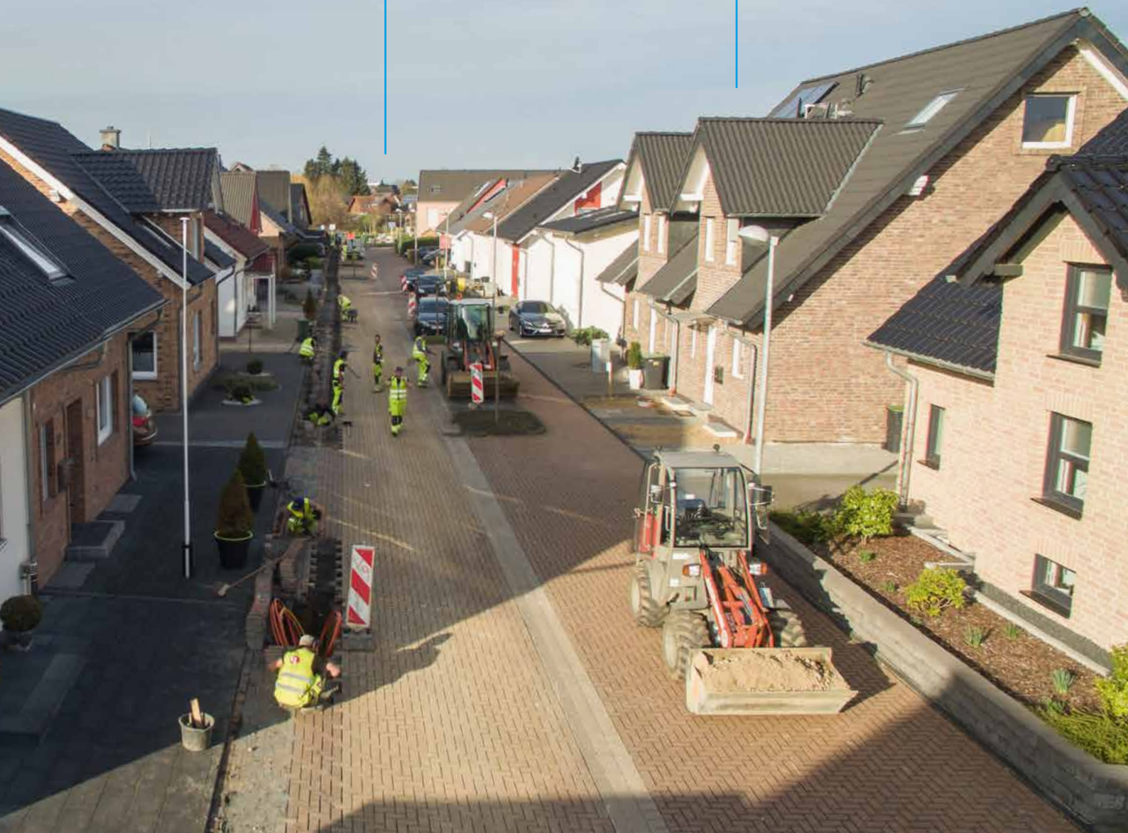
Der Mitarbeiter bedient die Fräse zum Ziehen des Grabens.
