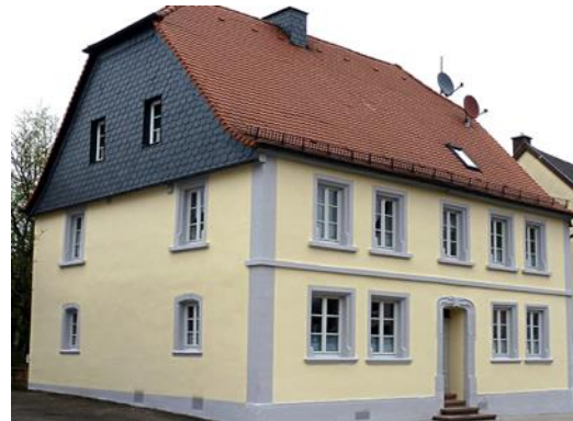
Steinwenden: Objektgerechte Fassadensanierung
