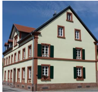
Steinwenden: Objektgerechte Dach- und Fassadensanierung
