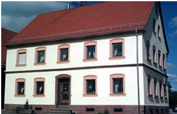
Mittelbrunn: Objektgerechte Dach- und Fassadensanierung
